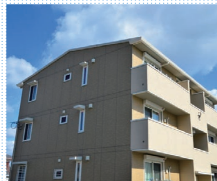
■アパート・マンション外壁
